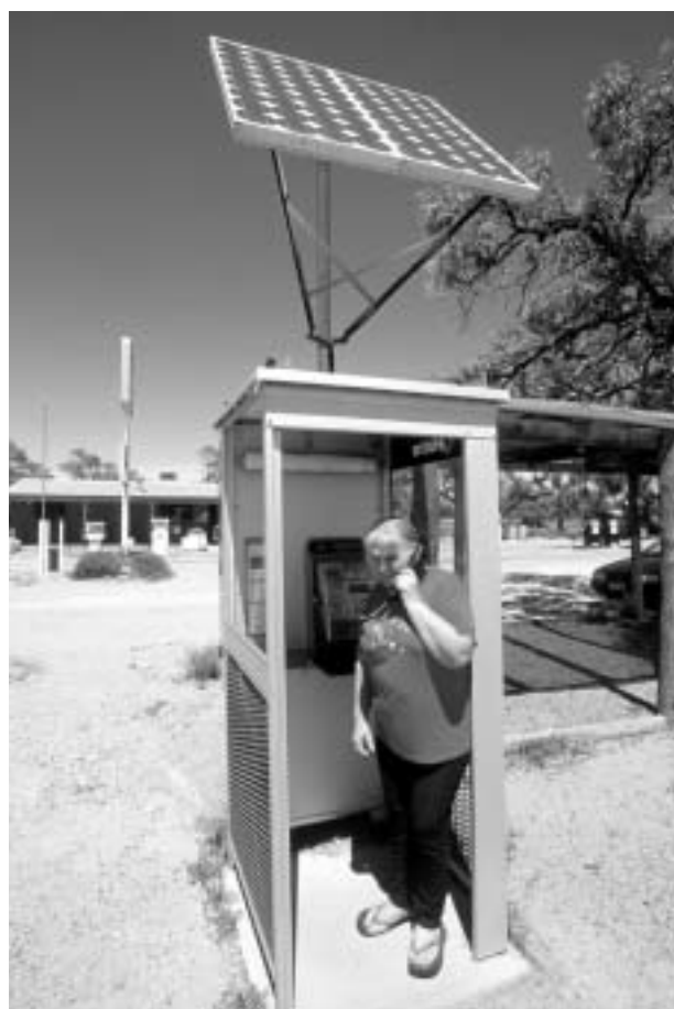
Cabine téléphonique alimentée par panneaux solaires © Autralian Greenhouse Office, Department of Environment and Heritage
