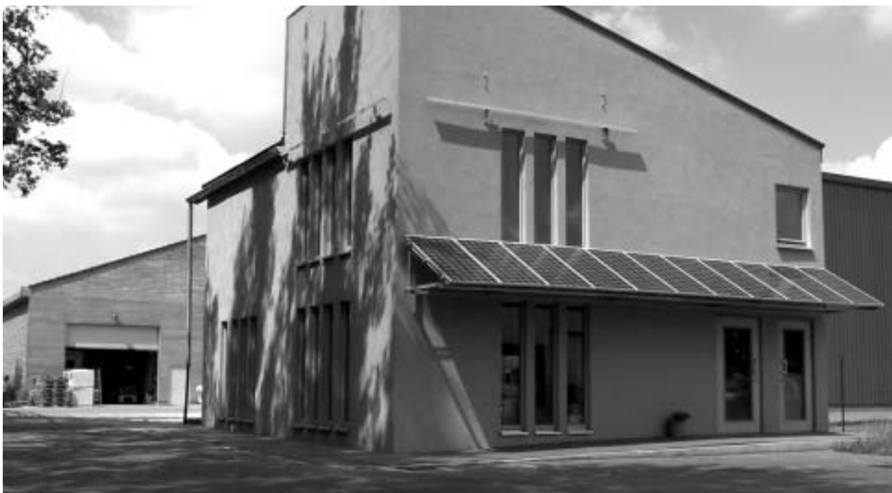
Immeuble de bureaux alimenté par des panneaux solaires
